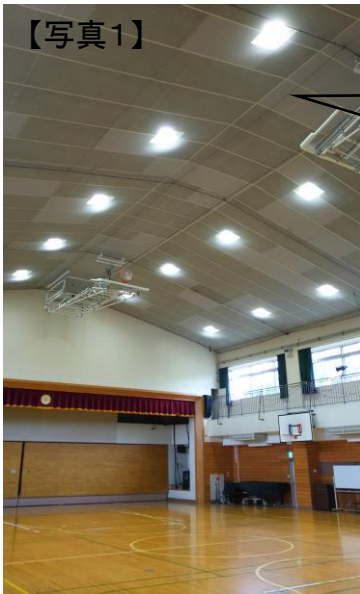
【写真1：耐震化工事後の体育館】
