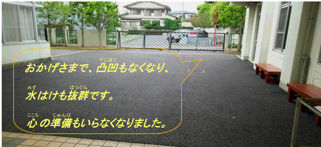
【写真2：舗装後の状況】
