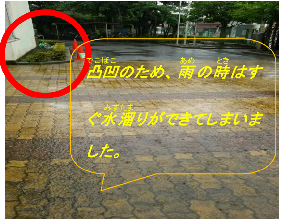
【写真2：舗装前の状況その2】
