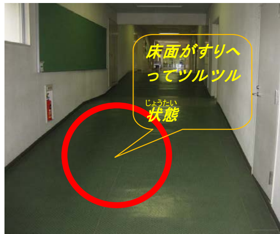
【写真2：旧 体育館前スロープ状況】
